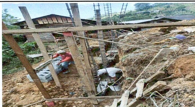
Foto1: Mejoramiento de muro iniciando con los cimientos
