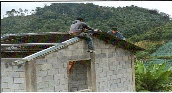
Foto 6: Mejoramiento de entechado
