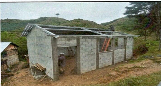
Foto 5: Espacio de ventanas se agregan 3
