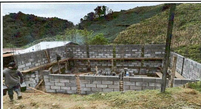
Foto 4: Mejoramiento de Puerta de entrada principal
