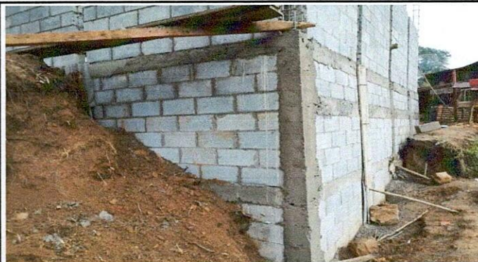
Foto 2: Mejoramiento de muro de contención sobre el que se deja el aula tipo portico
